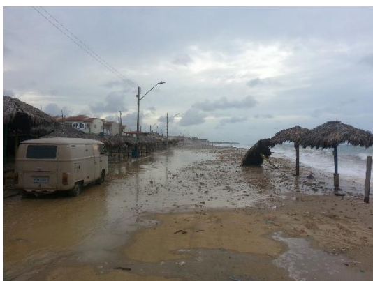
Figura 2 – Avenida litorânea de Icaraí, sendo alagada durante um evento de ressaca do mar.
