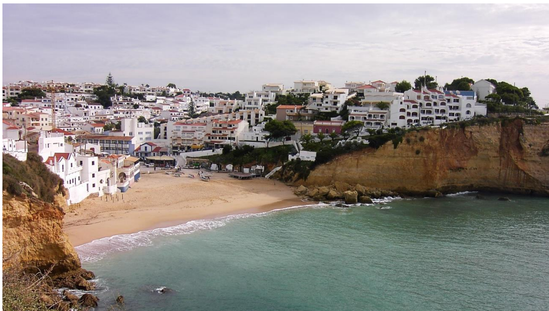
Figura 3 – Edificação em zonas de elevado risco: Praia do Carvoeiro, Algarve, Portugal, 2003; um exemplo da ocupação desregada que tem sido levada a efeito nas zonas costeiras (Foto: L.C. Fonseca).
