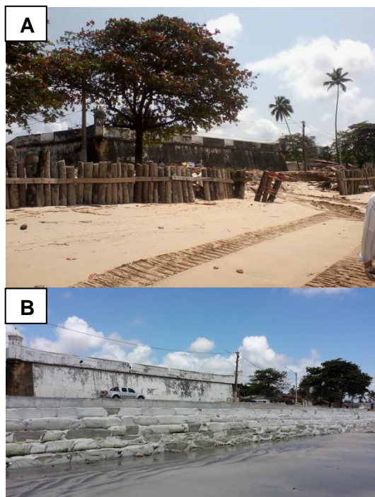
Figura 2 – A) Área degradada em frente ao forte de Pau Amarelo antes da construção do Bagwall ; B) Área recuperada após a construção do Bagwall no mesmo local.
